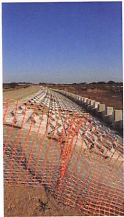
完成した仮設堤防
